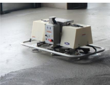
写真1 コンクリート床仕上げロボット作業状況
